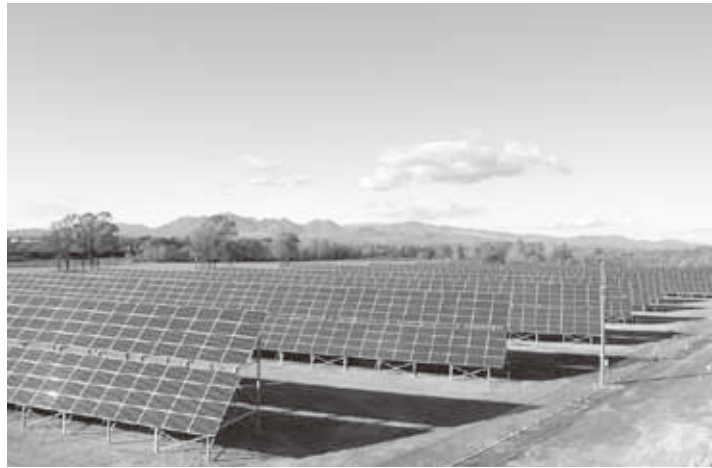
町は再生可能エネルギーの地産地消で地域活性化を(建設中のメガソーラー発電所)
