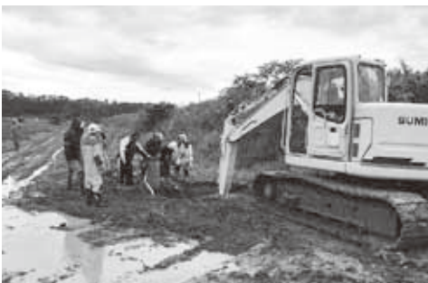
破損した配水管の復旧工事
