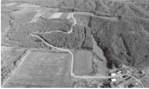
下居辺地区農道整備工事
