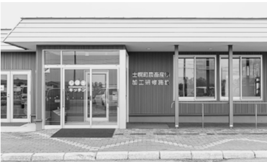
土幌町農畜産物加工研修施設（愛称：しほろキッチン）
