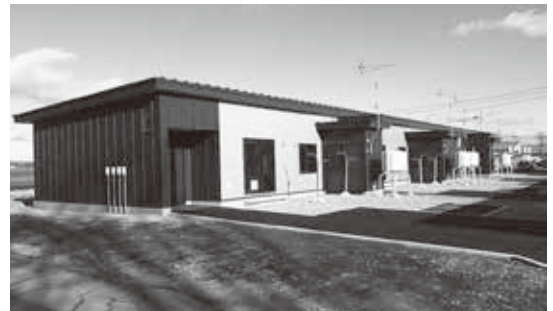
令和元年に建設された若葉団地
