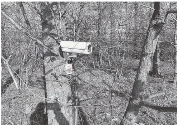
▶設置されたカメラ
