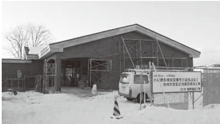
建設中の小規模多機能居宅施設
