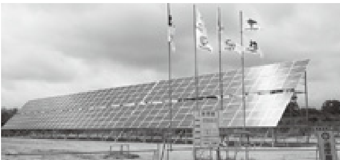
工事が進む中土幌太陽光発電所
