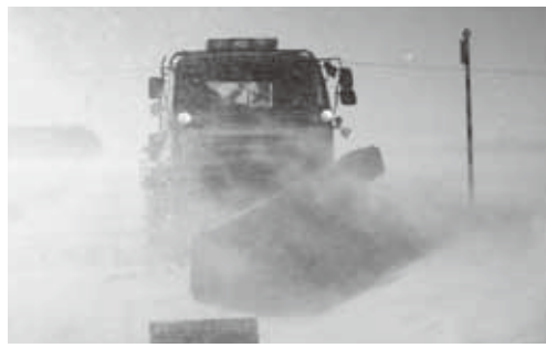
吹雪の中での除雪作業
