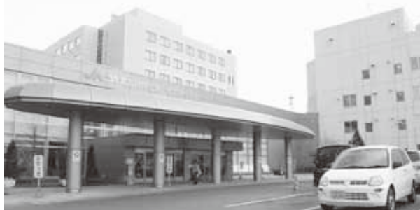
移転新築される帯広厚生病院
