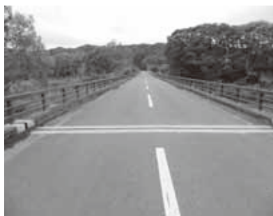
補修工事予定の更生橋(下居辺)
