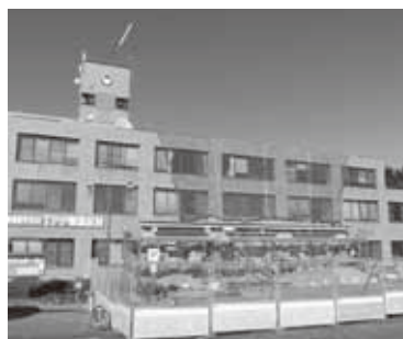
防災拠点となる庁舎の耐震工事
