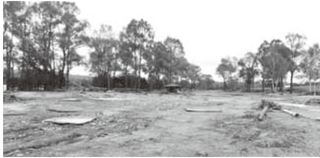
清流パークゴルフ場 被災状況
