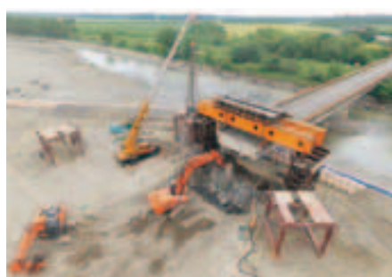
橋脚解体施工状況（7月6日）
