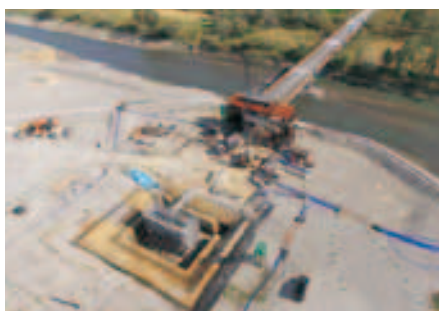
橋脚場所打杭（通常）生コン打設状況（9月26日）
