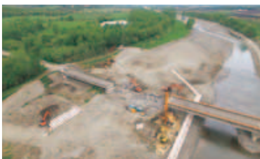
桁解体、主桁仮受け親杭置換施工状況（5月26日）
