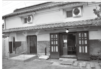
商家であった築150年の旧須田邸の蔵を改修した客室
