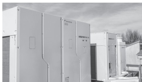
（特別養護老人ホーム施設整備 冷房設備改修）
