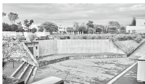
（役場北側擁壁改修工事）
