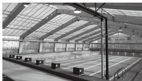
(LED照明器具工事 士幌町民プール)
