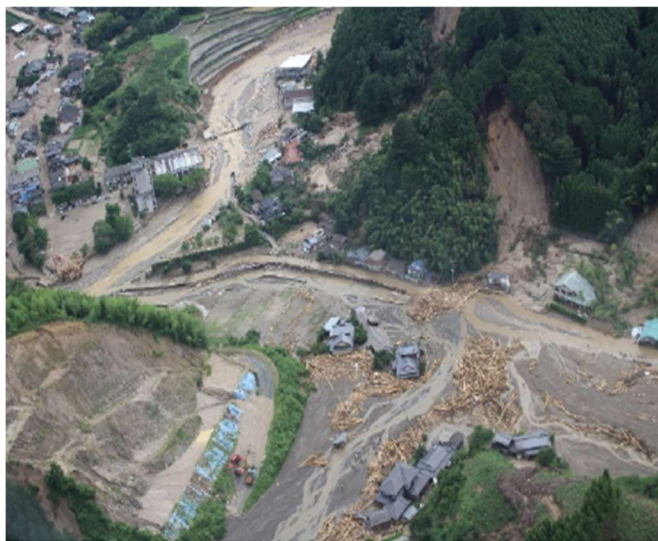
写真 2-2 朝倉市松末地区の被害状況（2017（平成 29）年九州北部豪雨災害）
