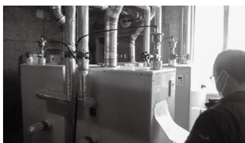
（消防庁舎ボイラー更新工事）
