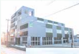
釧路町中園公園避難タワー
