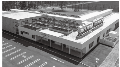
(認定こども園移転新築工事)
