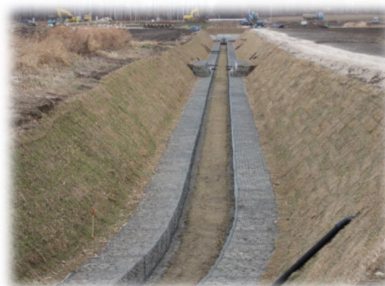
生態系配慮した明渠工事(フトン籠使用)
