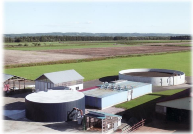
バイオガスプラント施設
