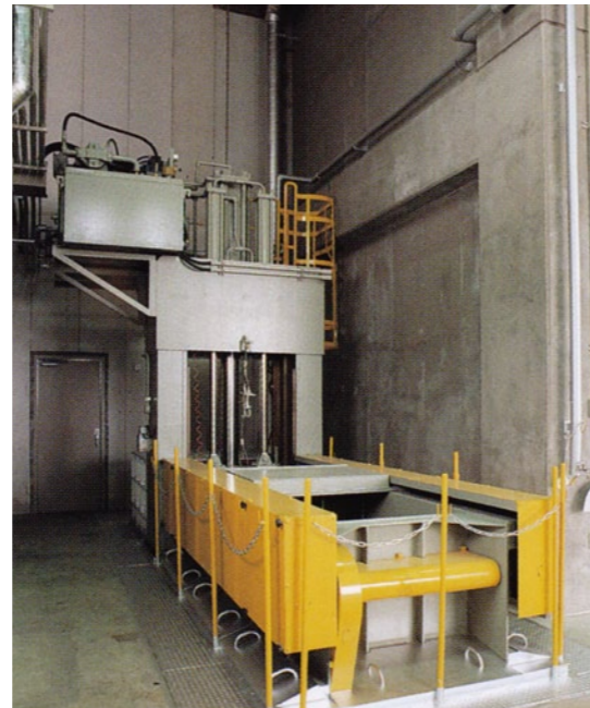
● 可燃性粗大ごみ破碎機(せん断式) か ねんせいそ だい ごみ は さい き だんしき たたみやタンスなどを切断し、燃えやすくします。
