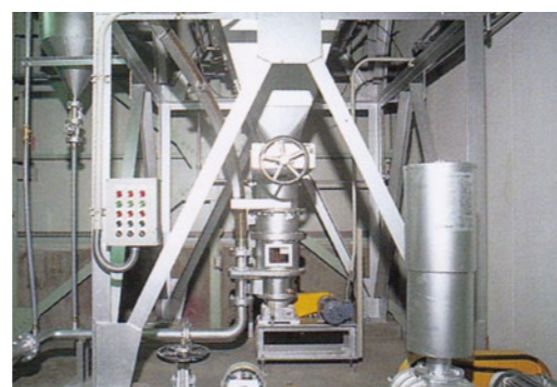
●有毒ガス除去設備 有毒ガスを取りのぞくための薬品をふきこみます。
