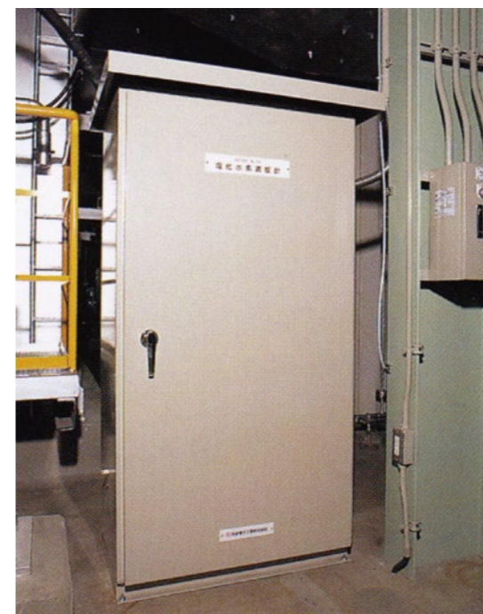
●塩化水素濃度計 排ガス中の塩化水素ガスの濃度を測定する装置です。
