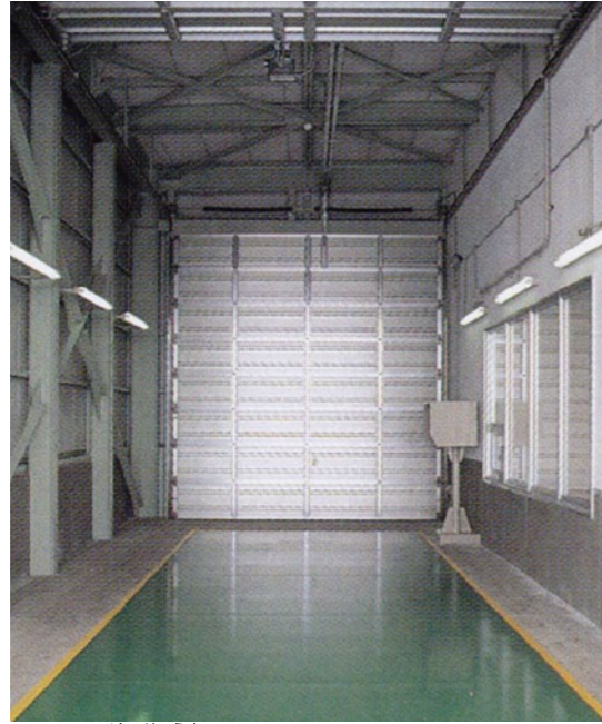
● ごみ計量機 けいりょうき ごみの重さを量ります。
