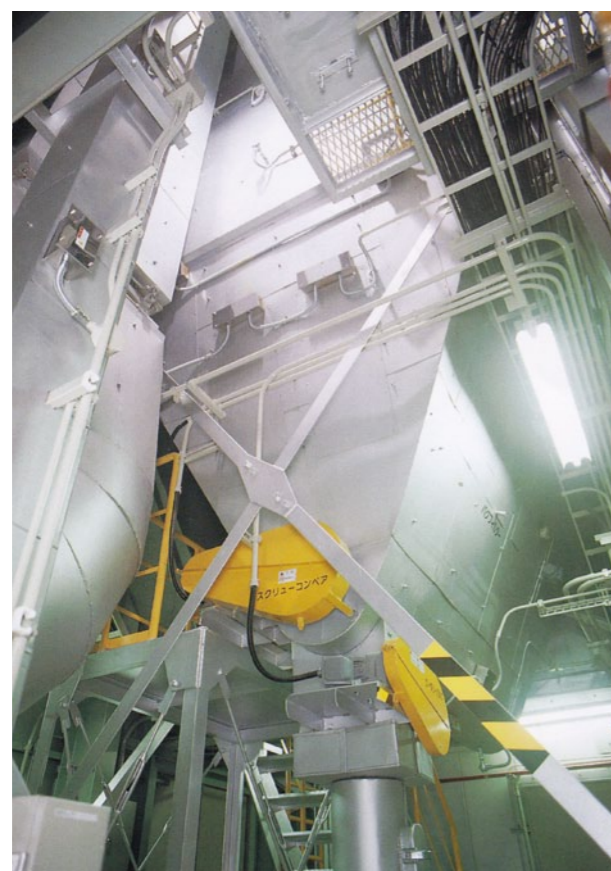
●バグフィルタ 排ガス中に含まれる灰を取りのぞく機械です。
