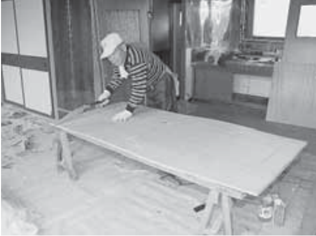
住宅改修工事を営繕会に発注
